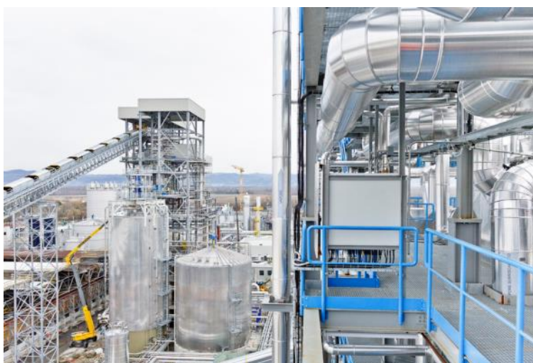
Figura 4-47 – Área de pré-tratamento e hidrólise enzimática [301]
