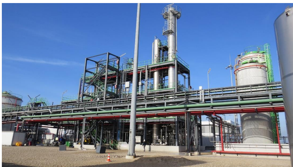
Figura 2-23 – Unidade de transesterificação com catálise homogênea alcalina, integrando a separação de fases, a lavagem do biodiesel, a recuperação do metanol e o tratamento do glicerol – Lurgi AG (Cortesia da Fábrica Prio)
