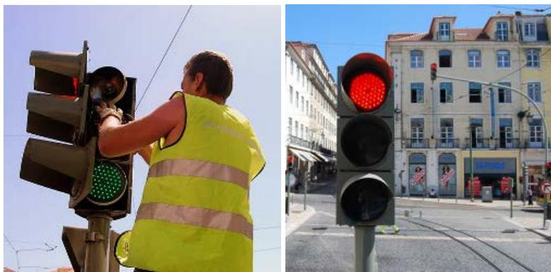
**LISE\_TCO2 – SUBSTITUIÇÃO DE LÂMPADAS INCANDESCENTES POR LED EM TODOS OS SEMÁFOROS DO EIXO MARQUÊS POMBAL – RESTAURADORES**
