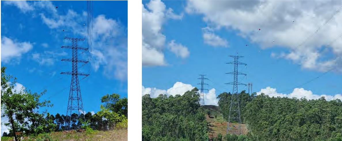
Figura 3 - Exemplos de apoios duplos apenas com 1 terno instalado (do lado direito de cada apoio), disponíveis para receber um segundo terno no lado esquerdo do apoio. Fonte própria, 2024.
