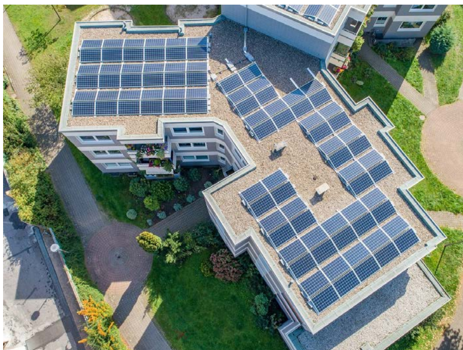
Figura 3 – Sistema fotovoltaico de um ACC instalado numa parte comum (terraços) de um condomínio
