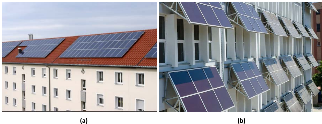
Figura 4 – Exemplos de sistemas fotovoltaicos de ACC instalados em outros tipos de partes comuns de edifícios de um condomínio: (a) telhados; e, (b) fachada principal.
