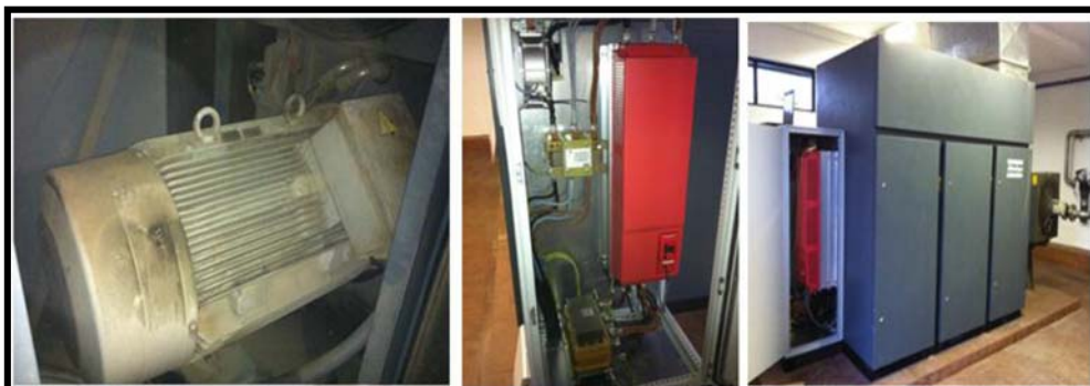
Figura 2-8 - Imagens da implementação da medida ADENE_T11
