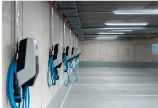
**Figura 2** – Garagem de condomínio sem *boxes* com vários pontos de carregamento de VE
