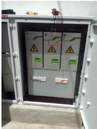
Armário de regulação de fluxo luminoso instalado em Campo Maior
