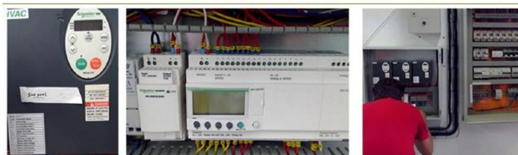
Figura 2-28 - Imagens da implementação da medida MTEJO_TO1
