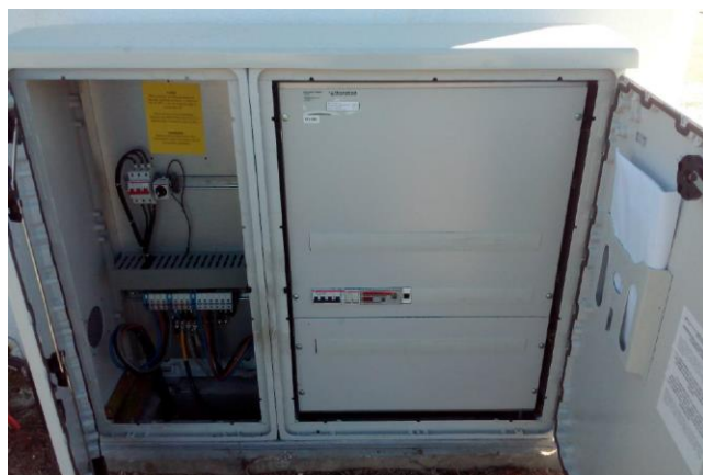
Posto de transformação intervencionado
