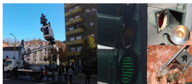
Instalação de óticas
