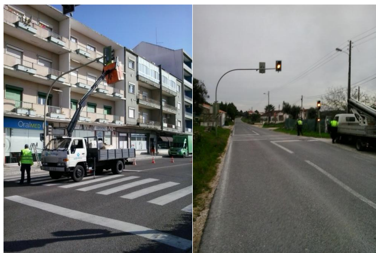
Figura 2-23 - Imagens da implementação da medida CIMLT_TO2
