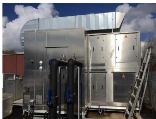
Montagem da nova UTAD na Piscina Municipal de Porto de Mós
