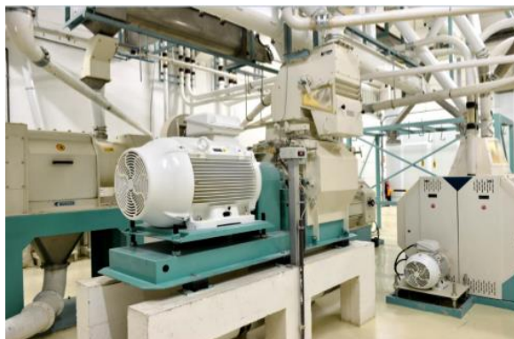
Figura 2-4 - Imagens da implementação da medida EDPC_TI3
