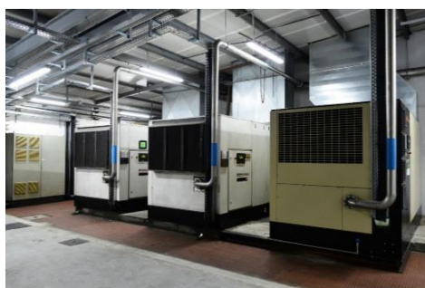
Figura 2-1 - Imagens da implementação da medida EDPC_TI4
