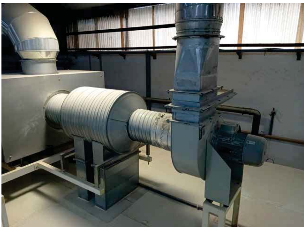
Figura 72 - Exemplo de ventilador de estufa com motores de alto rendimento
