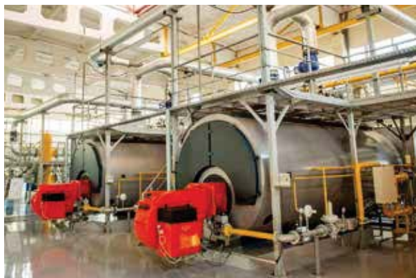
Figura 54 - Caldeira de produção de vapor (fonte: Icaterm)
