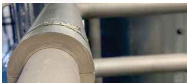
Figura 57 - Aplicação de isolamento térmico em condutas (fonte: va-Q-tec)
