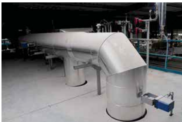
Figura 56 - Sistema de condutas de recuperação de ar quente de um forno para secadores
