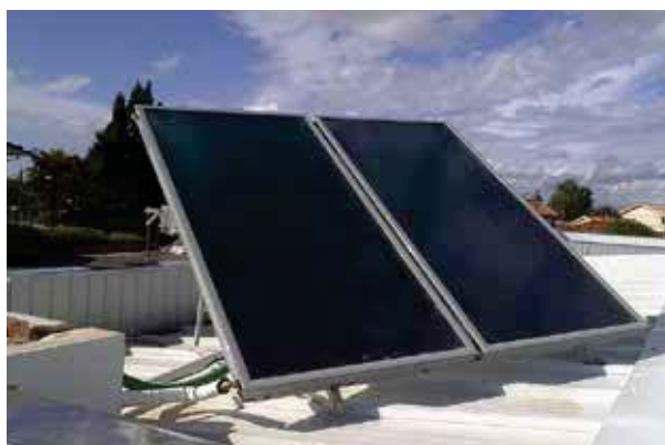
Figura 58 - Painéis solares térmicos (fonte: ExtraEnergia)
