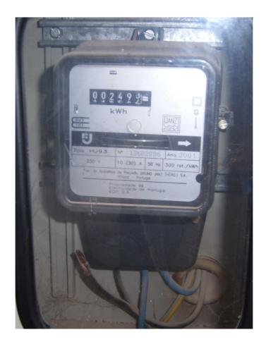
**Nota**: Para além da tecnologia adotada (com mais de 100 anos) é de relevar a idade já do próprio contador (17 anos) e a falta de segurança resultante da falta de isolamento do condutor proveniente da rede de distribuição. Está, como é normal na EDPD, tudo mal.
