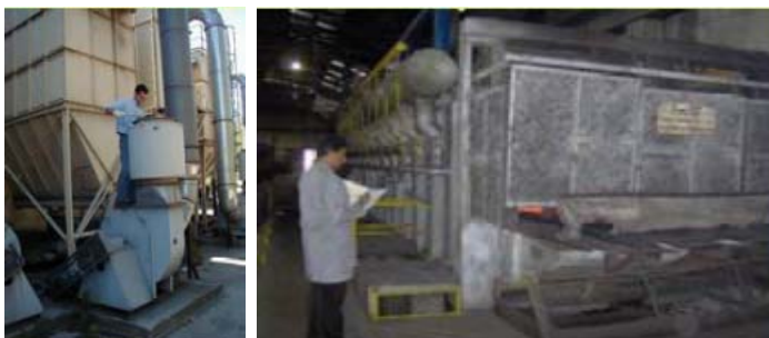
Figura 2-7 - Imagens da medição dos equipamentos onde se afigura um maior potencial de economia de energia
