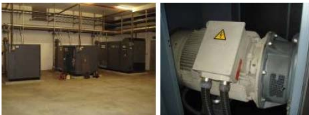
Vista do motor do compressor
