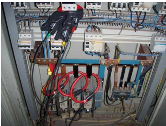
Figura 2-8 - Imagem da medição no quadro geral de entrada
