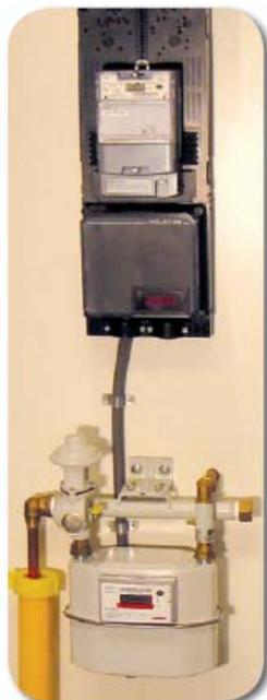
**Figura 21:** Solução para contador inteligente para gás natural na Holanda.
